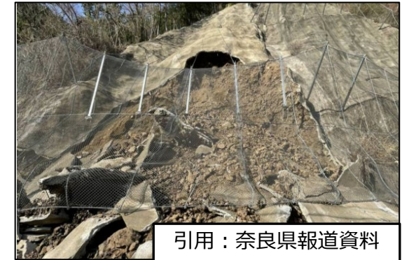
上図：モルタル吹付のり面の崩落事例
